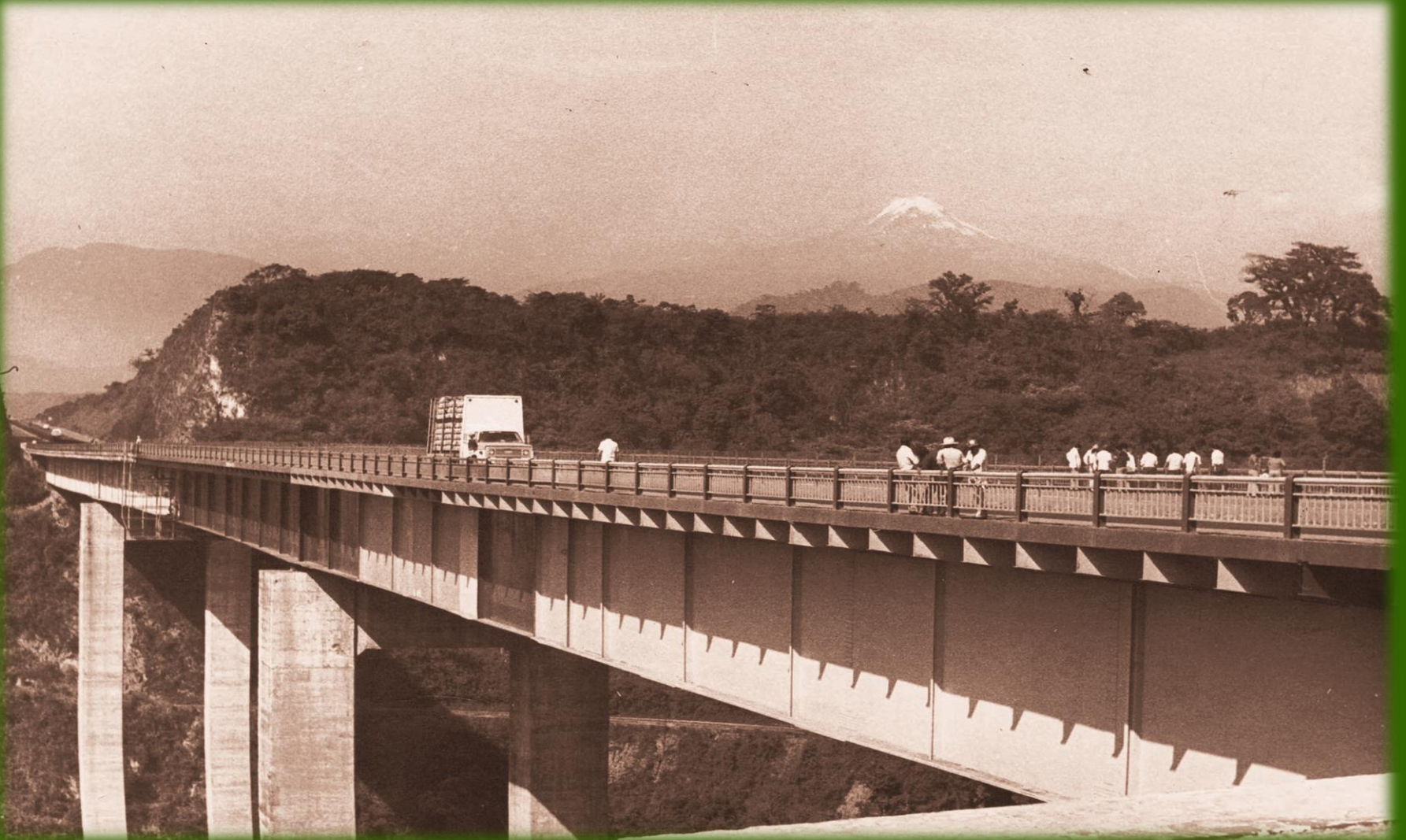
Puente Mariano García Sela, Autopista Cd. Mendoza - Córdoba
